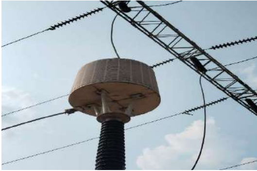
FIG:4.5: WAVE TRAP
